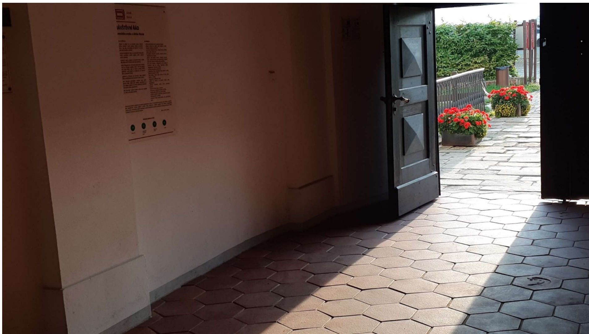
Foto po skončení obnovy
