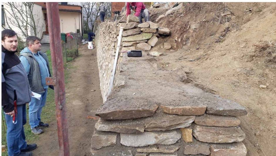
Foto z opravy zdi
