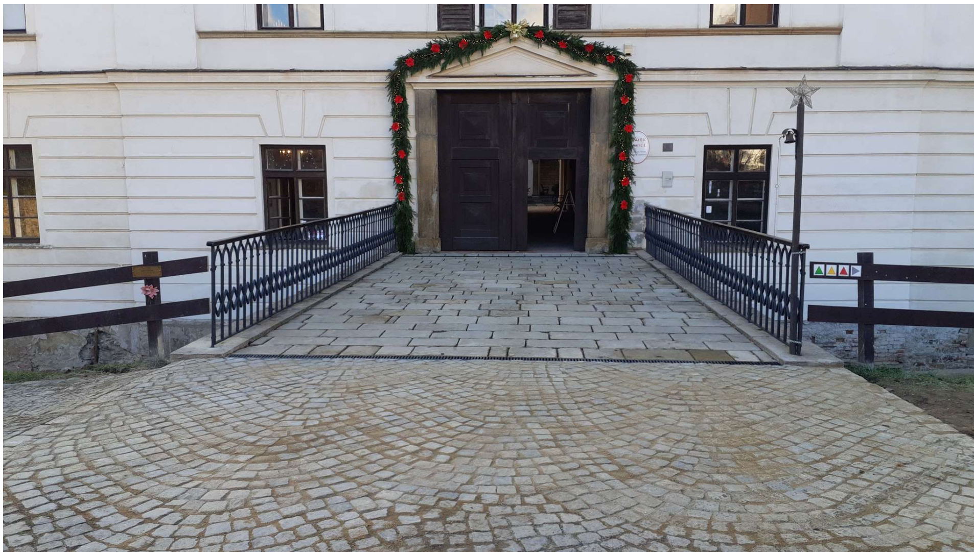
Foto mostu po opravě
