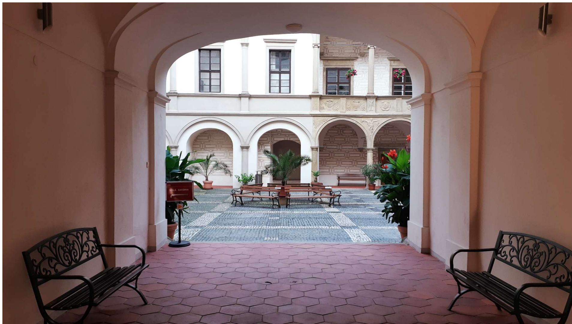
Foto po skončení obnovy
