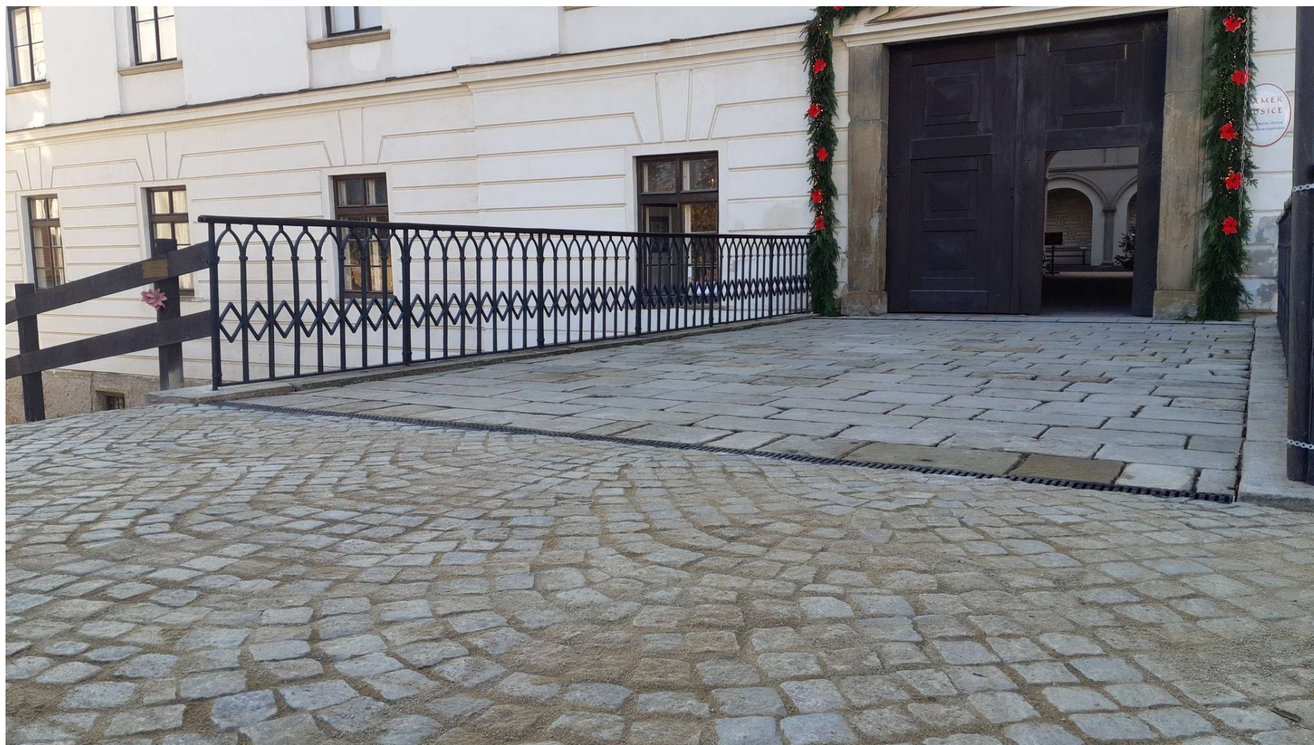
Foto mostu po opravě
