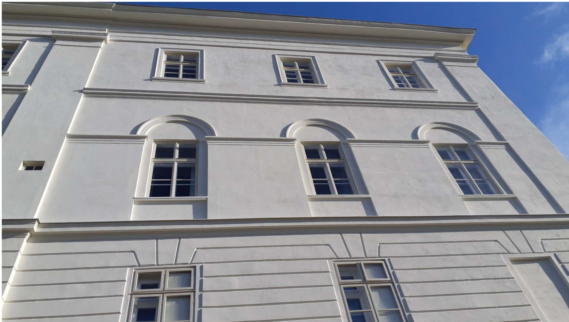
Foto opravené západní fasády
